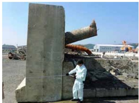
津波により破壊し撤去された棧橋(石巻漁港)
