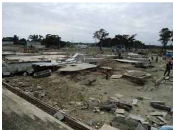
津波による被災状況(七ヶ浜町)
