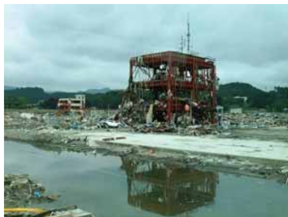
防災対策庁舎周辺の地盤沈下(南三陸町志津川)
