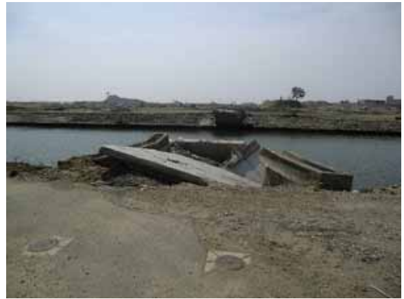
屋根と岸壁側の壁の全てが破壊された市場。
