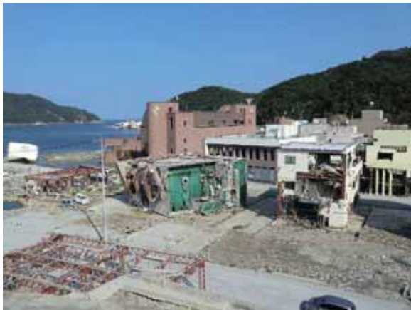
押し波により転倒した杭基礎の建物。
