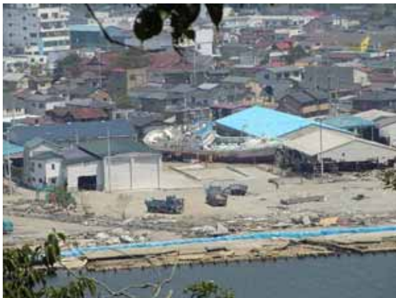
石巻港では、高知県土木部の廣末氏と安田氏に休日にもかかわらず、被災状況の説明をして頂いた。津波高は 6m、地盤沈下量は 1m、漁港は地盤沈下により機能喪失したとして岸壁、道路等施設は平成 24 年内の完全復旧、破堤した防潮堤は平成 25 年の台風期前をめざして復旧を進めているとのことであった。
