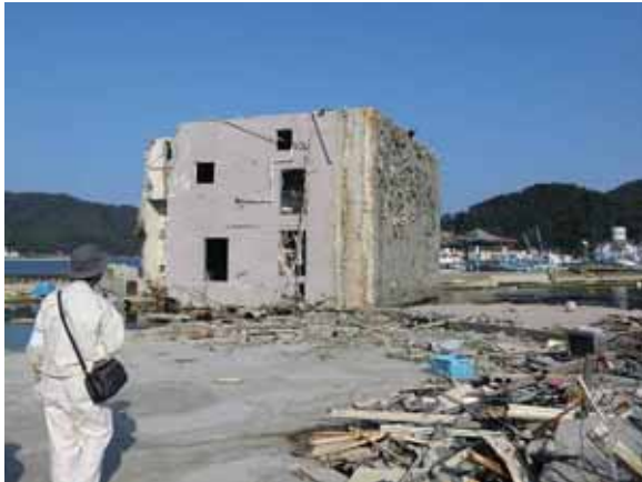
押し波により転倒した杭基礎の建物。
