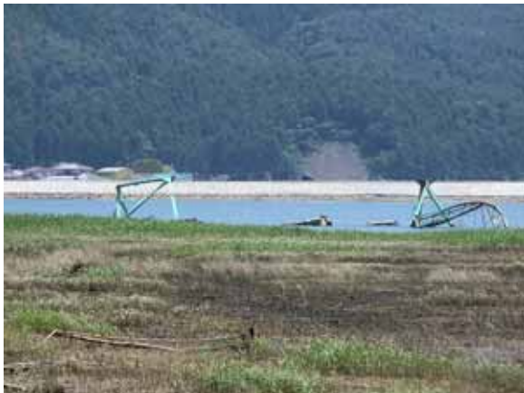
漁船が津波で流され、凶器となって破壊した工場。
