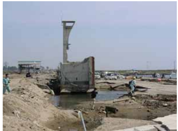
屋根と岸壁側の壁の全てが破壊された市場。
