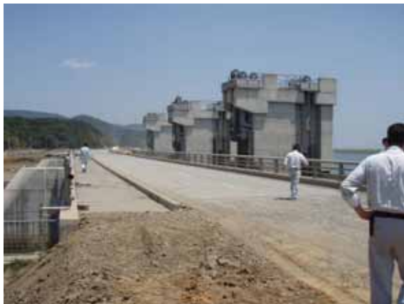
月浜第一水門と PCT 桁橋。皿貝川と北上川の
