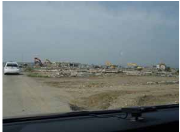
撤去作業が完了している住宅地跡
