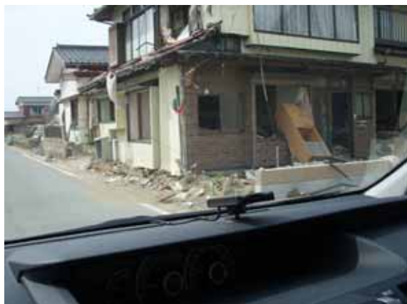
撤去作業が進んでいない地区
