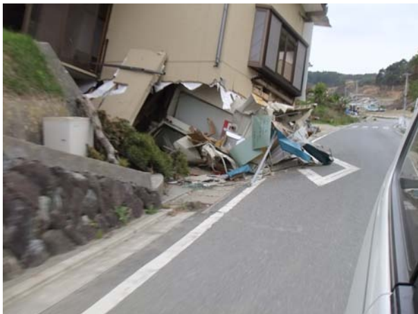
写真：道路にはみ出した住宅の瓦礫
