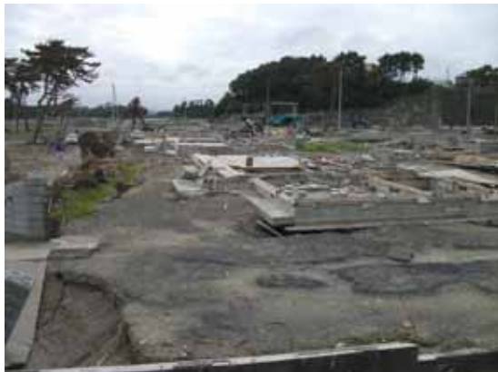
津波で破壊された町の様子
