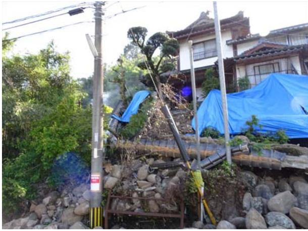
写真 3-9 被災後（石積み擁壁）
