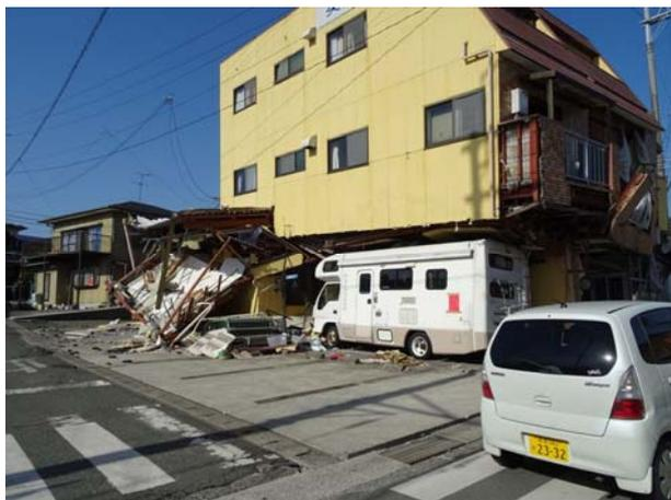
写真 3-20 被災後 (S造4階建て)
