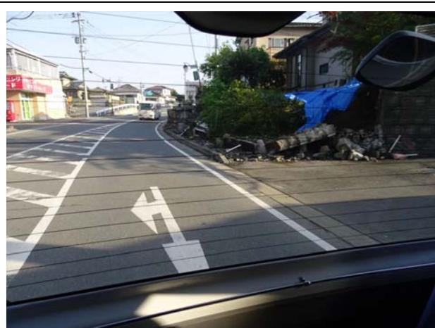
写真 3-1 ブロック積み擁壁の倒壊
