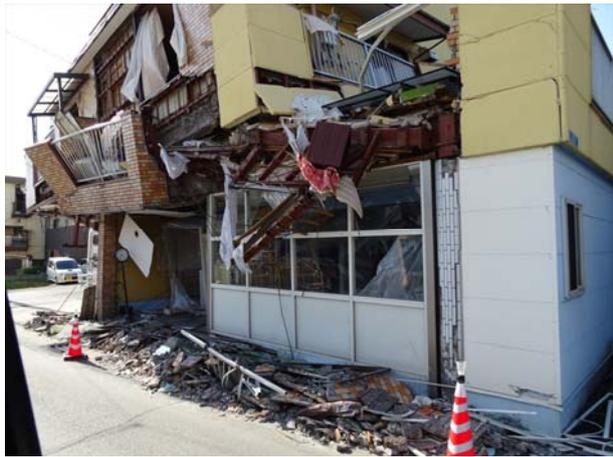
写真 3-16 被災後 (S造4階建て)
