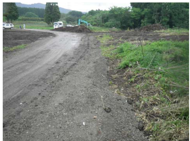
図 2 砕石舗装の作業道
