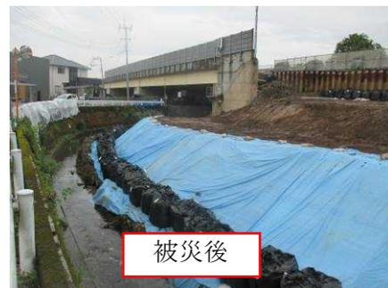
▲ 交差点より南側に位置する九州自動車道の秋津川橋では、橋台背面の擁壁を含む盛土部が崩壊。
