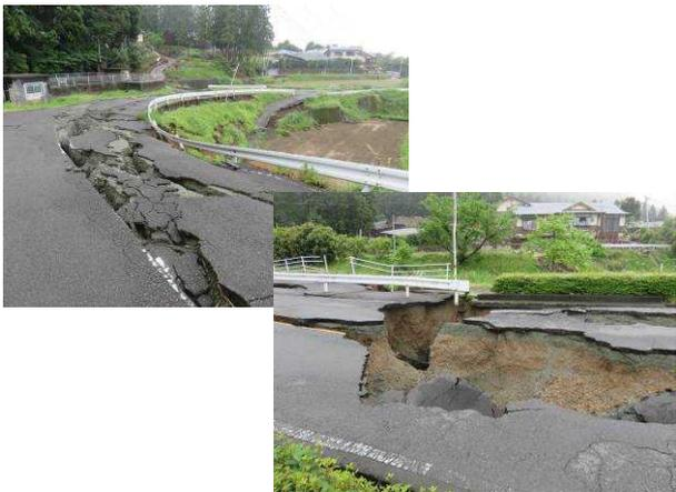
▲舗装・土工部被災状況（県道 28 号）。改良時に拡幅した盛土部の被害が大きい。
