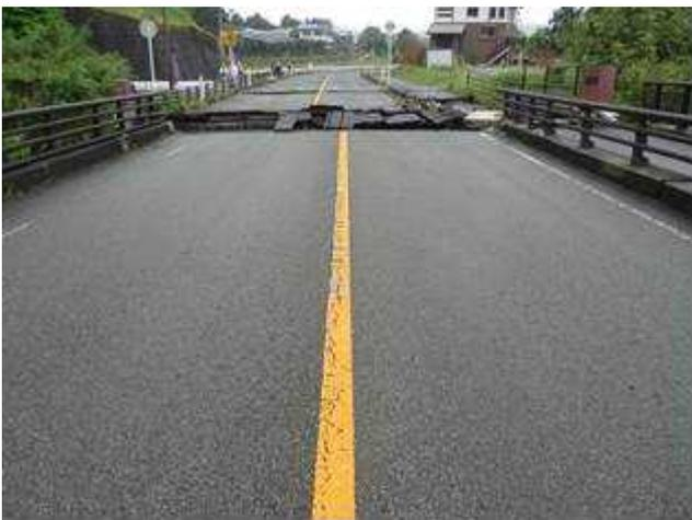
▲大切畑大橋：路面の段差（0.4m 程度）。伸縮装置の破損。
