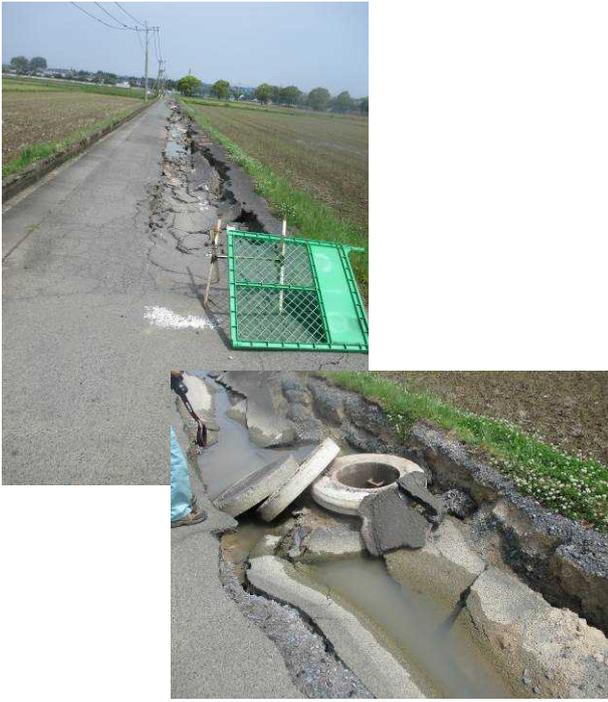
▲下水管理設部の液状化，マンホールの浮き上がり。
