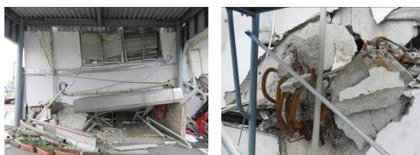
▲RC柱が座屈破壊しており鉄筋には腐食の進行が確認された。
