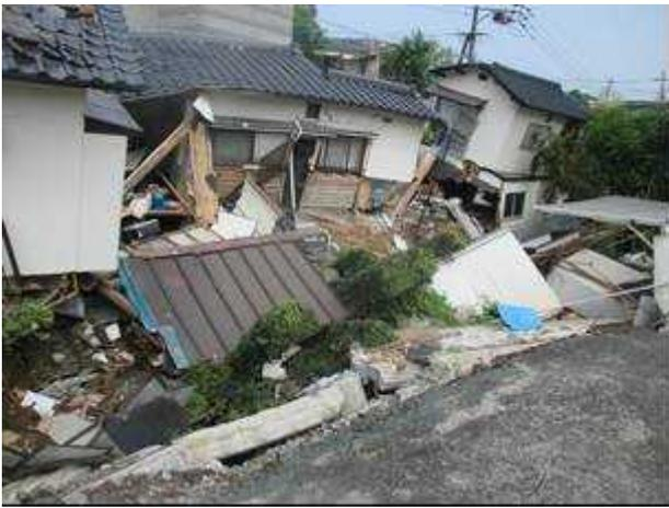
▲寺迫交差点付近 443 号沿線の家屋の倒壊。川側への擁壁の転倒に伴い宅地が不安定化。
