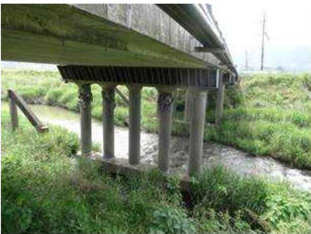
▲第一畑中橋（パイルベント橋脚式 3 径間単純 PC 床版橋）：橋台背面の沈下、橋脚の損傷により前面通行止め。各下部工には、橋軸方向への落橋防止目的の鋼製桁座拡幅が施工済み。
