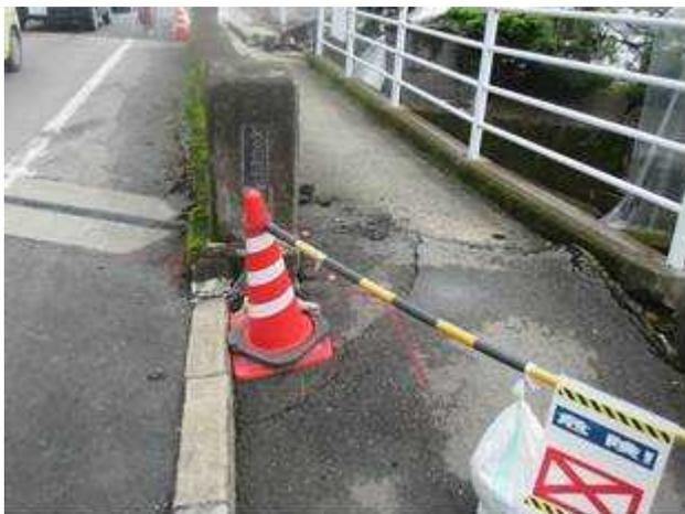
▲妙見川を渡河する福富橋（県道 28 号）の橋台背面の損傷。車道部はオーバーレイによる応急対策済みであった。
