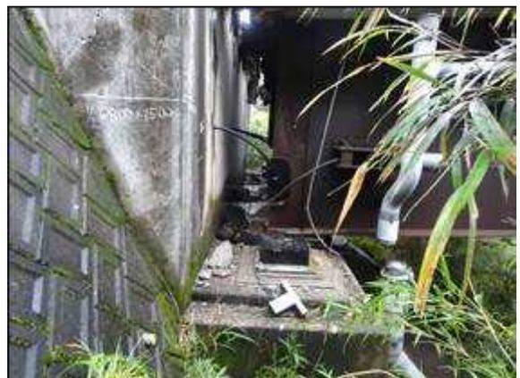
▲大切畑大橋：落橋防止ケーブルの破断。
