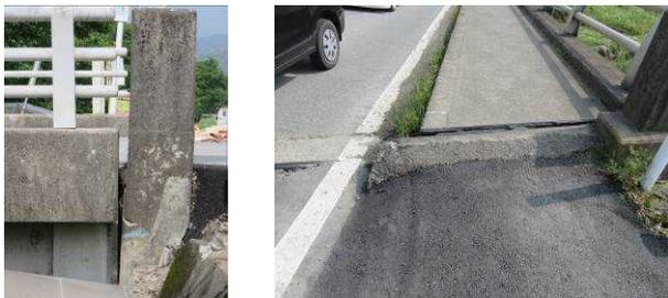
▲木山橋：パラペットの破壊。橋軸直角方向への桁移動。
