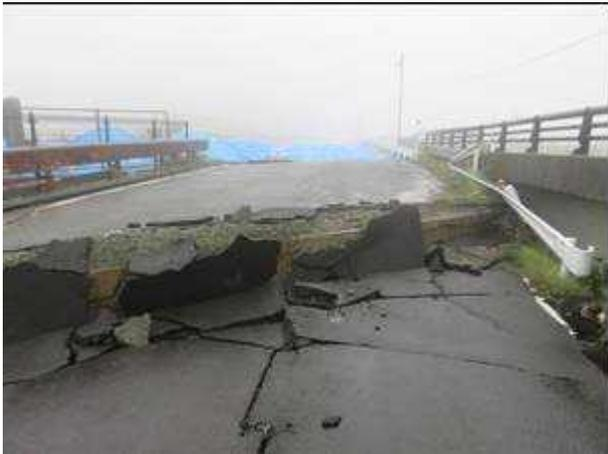
▲大切畑ダム橋（平成 10 年 3 月 単純 PCT 桁橋）に隣接する単純プレートガーター橋の橋台背面の状況。施工年次が古く踏掛板が設置されていないため、段差が著しい。
