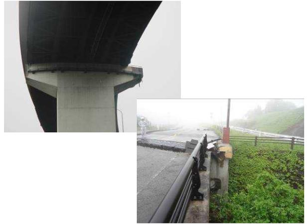
▲大切畑大橋：橋軸直角方向（谷側）への移動（1.1m 程度）。
