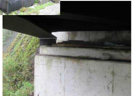
▲大切畑大橋：積層ゴム支承の破断，橋軸直角方向サイドブロックの破断。
