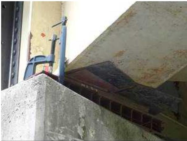
▲秋津川橋：支承部は確認できなかったが，応急処置として桁下と桁座の間に鋼材を敷き込み，万力で下フランジと固定する応急処置が施されていた。
