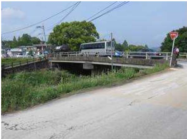
▲秋津川を渡河する木山橋（2径間PCT桁）：橋台の沈下が確認された。
