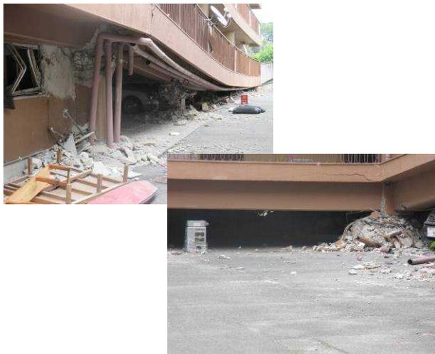
▲RC造集合住宅の1F駐車場部分の圧壊。RC柱の破壊。
