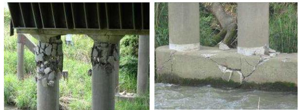
▲第一畑中橋：中間橋脚は桁受け梁との結合部で主たる破壊。橋軸直角方向に地震荷重が卓越したものと推察される。
