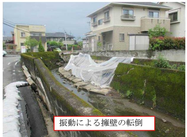
▲福富橋より上流側の護岸（モタレ式コンクリート擁壁）は，広範囲に渡り倒壊。地盤の緩み（液状化など）に起因する沈下やすべり，振動による転倒などが確認された。
