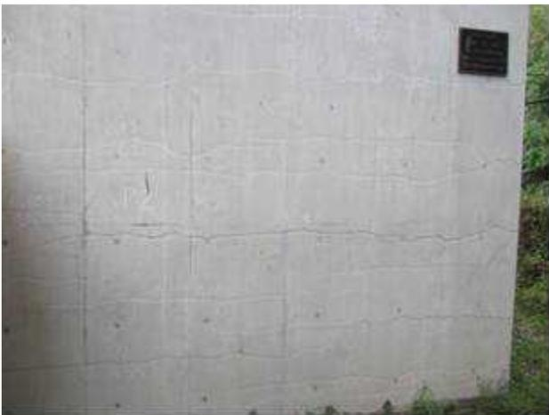
▲大切畑大橋：橋脚基部ひび割れ（最大 4mm, 4.0m 程度）。
