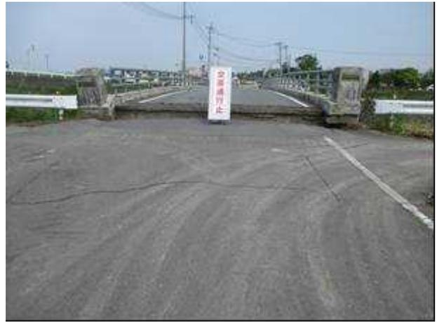
▲第一畑中橋：橋台背面の段差 70cm 程度。
