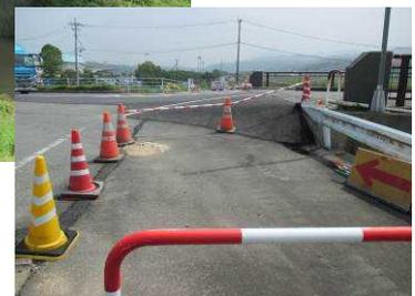
▲新木山橋（単純 PCT 桁橋）：橋台背面の段差 70cm 程度。舗装は応急復旧済み。
