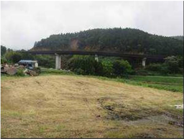
▲本地震で大きな被害を受けた県道 28 号に位置する大切畑大橋は、平成 13 年 3 月に施工された曲線を有する 5 径間連続プレートガーター橋。
