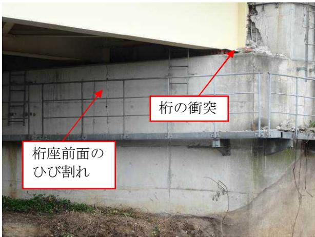
▲秋津川橋：橋桁の橋軸方向への移動によるパラペットとの衝突，桁座前面の鉛直方向ひび割れ。
