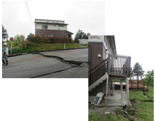
▲大切畑大橋近傍に位置する民家。周辺の被害状況と比べると建物外観の被害は軽微であったが、宅地に亀裂が生じており危険と判断されていた。
