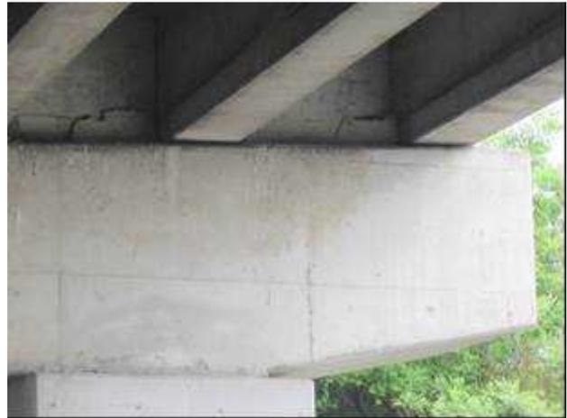
▲ 福富地区交差点橋梁 (九州自動車道) : 支点部の横桁端部に今回の地震の影響と見られるひびわれを確認。
