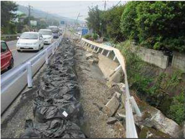
▲寺迫交差点付近 443 号沿線の擁壁（ブロック積擁壁）の倒壊。
