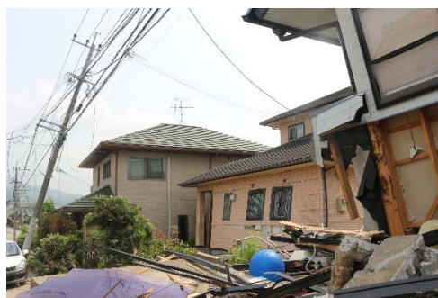
一番奥の家屋は建物自体は被害が軽微であるが隣接する家屋の倒壊による影響を受けた状況
