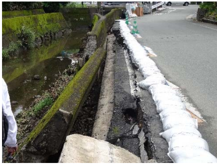
橋梁上流の護岸の状況
