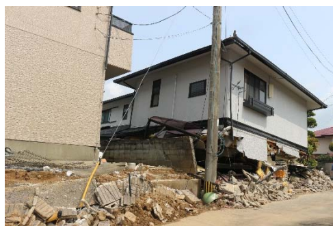
比較的に新しい家屋の状況倒壊
