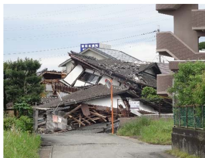
昔ながらの瓦屋根の倒壊状況
