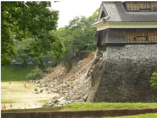
写真4 熊本城の被害状況1
