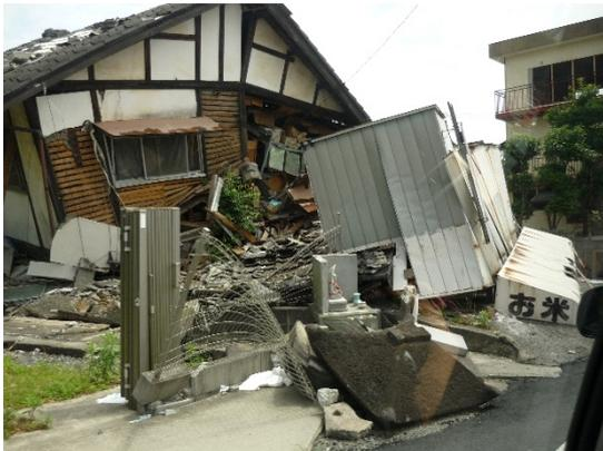
写真 10 益城町での家屋の被害状況 3
