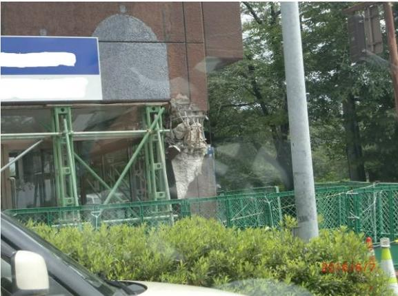
折れかけの鉄筋コンクリートの柱
