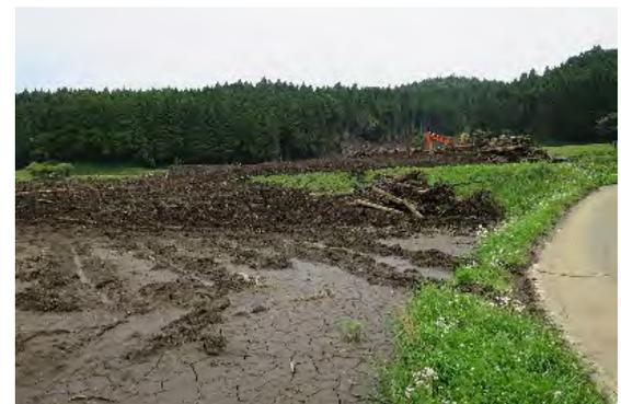
写真-2.6.10 山王谷川下流域の土石流氾濫堆積状況
