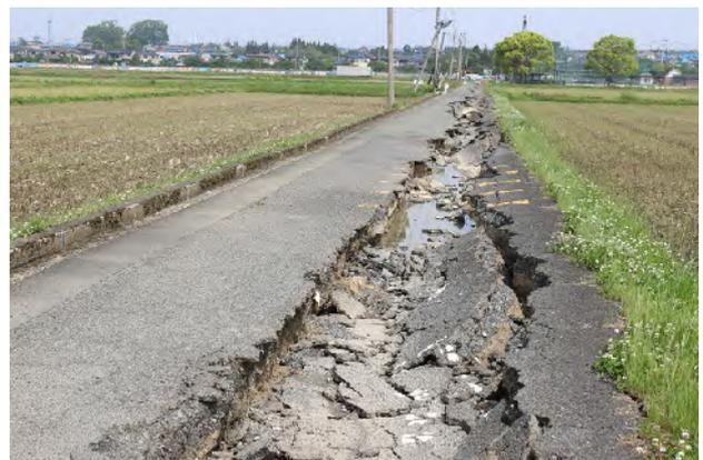
写真-2.5.1(5) 益城町安永(秋津川の南側水田地帯)の道路における下水道工事埋戻土の液状化被害
