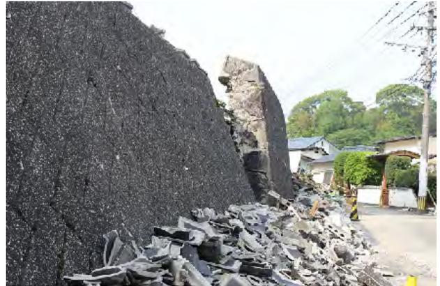
写真-2.2.10 起き上がったブロック積み擁壁
