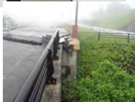
写真-2.4.7 橋軸直角方向への桁移動
