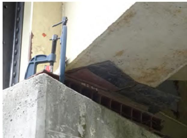
写真-2.4.4 支承部の応急復旧状況
