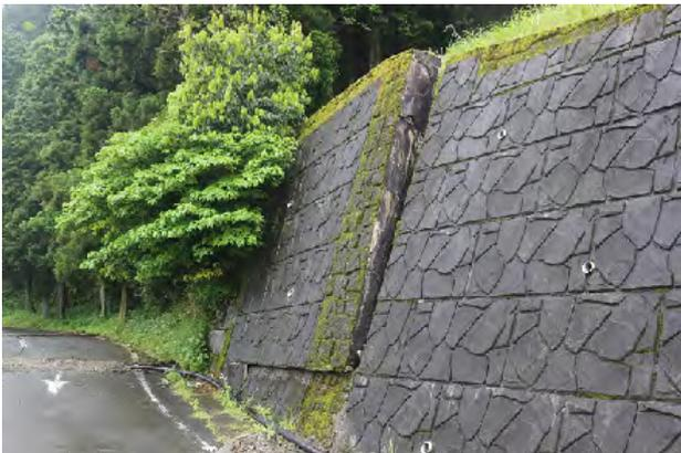
写真-2.2.3 前方へ押し出された県道28号山留め擁壁
