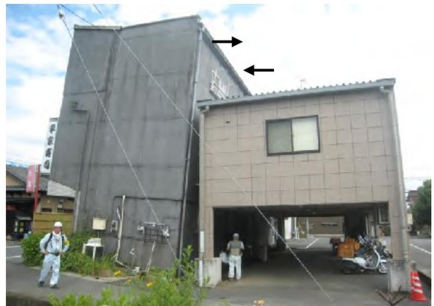
写真-2.5.4(1) 西熊本駅周辺の建物被害状況（不同沈下被害）
