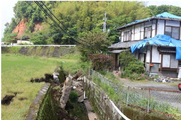
写真-2.2.7 断層が横断した箇所の護岸
