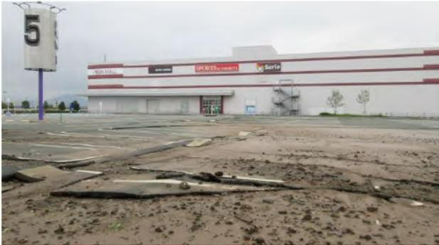
写真-2.5.3(1) 地盤工学会による調査時の噴砂状況<sup>4)</sup>
