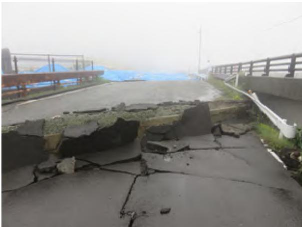
写真-2.4.12 橋台背面の沈下状況
