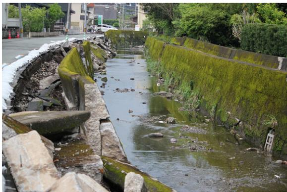
写真-2.2.12 東側に滑動した護岸
