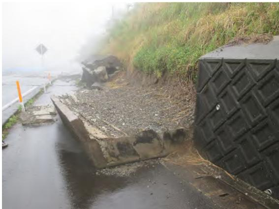
写真-2.4.11 橋台背面山留め擁壁の転倒
