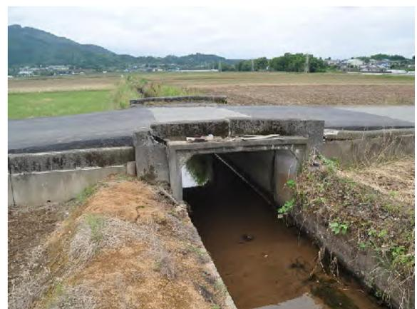
写真-2.3.3 端ブロック背面の盛土状況
