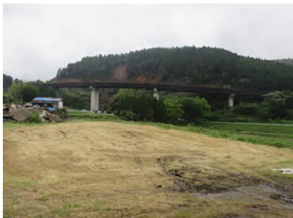
写真-2.4.5 橋梁背面の斜面は広範囲に崩壊
