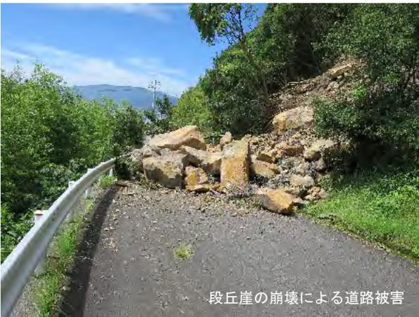
段丘崖の崩壊による道路被害
