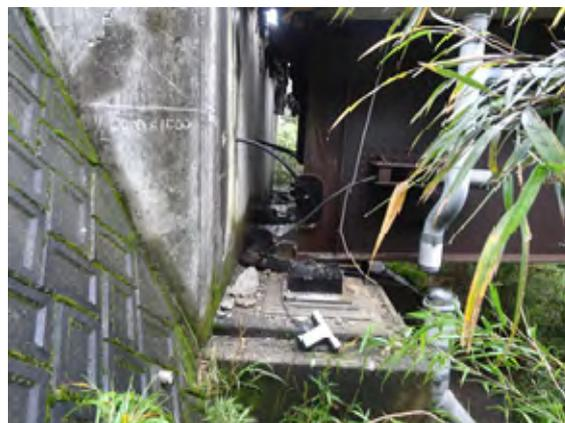
写真-2.4.9 落橋防止ケーブルの破断
