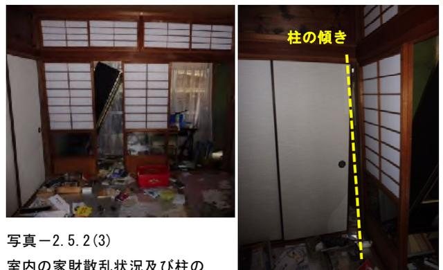
写真-2.5.2(3) 室内の家財散乱状況及び柱の傾き状況
