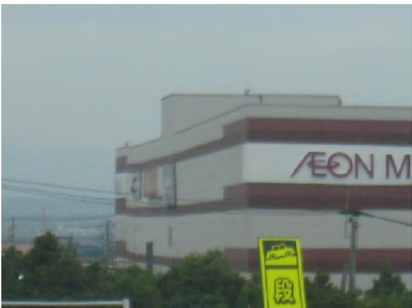
写真-2.5.3(3) 緑川・著町橋より撮影したイオンモール熊本の建物（建物中央付近が沈下している）
