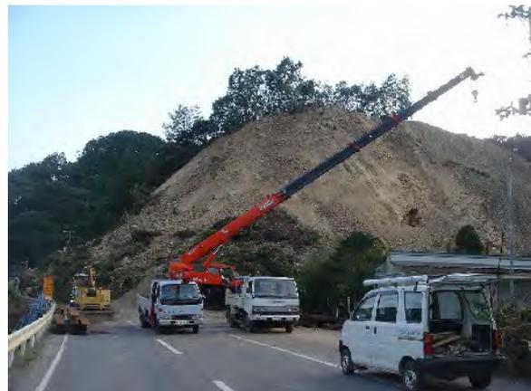
写真-2.6.11 高知県における凸状尾根地形の斜面崩壊例
