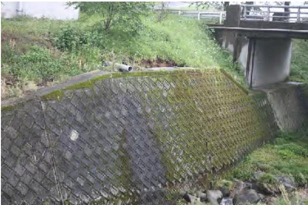
写真-2.2.1 前方へ押し出された大切畑河川護岸
