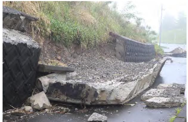
写真-2.2.5 転倒した県道28号の山留め擁壁
