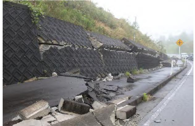
写真-2.2.4 中央が折れ曲がった県道28号の山留め擁壁
