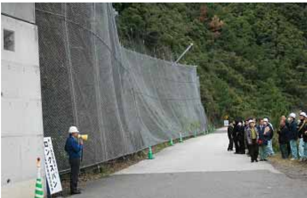
高知県内の企業、地盤工学会四国支部、愛媛大学防災情報研究センターの共同で開発したポケット式落石防護ネット。横ロープに緩衝金具を装着しているのので、エネルギー吸収性能、耐衝撃性能に優れている。
